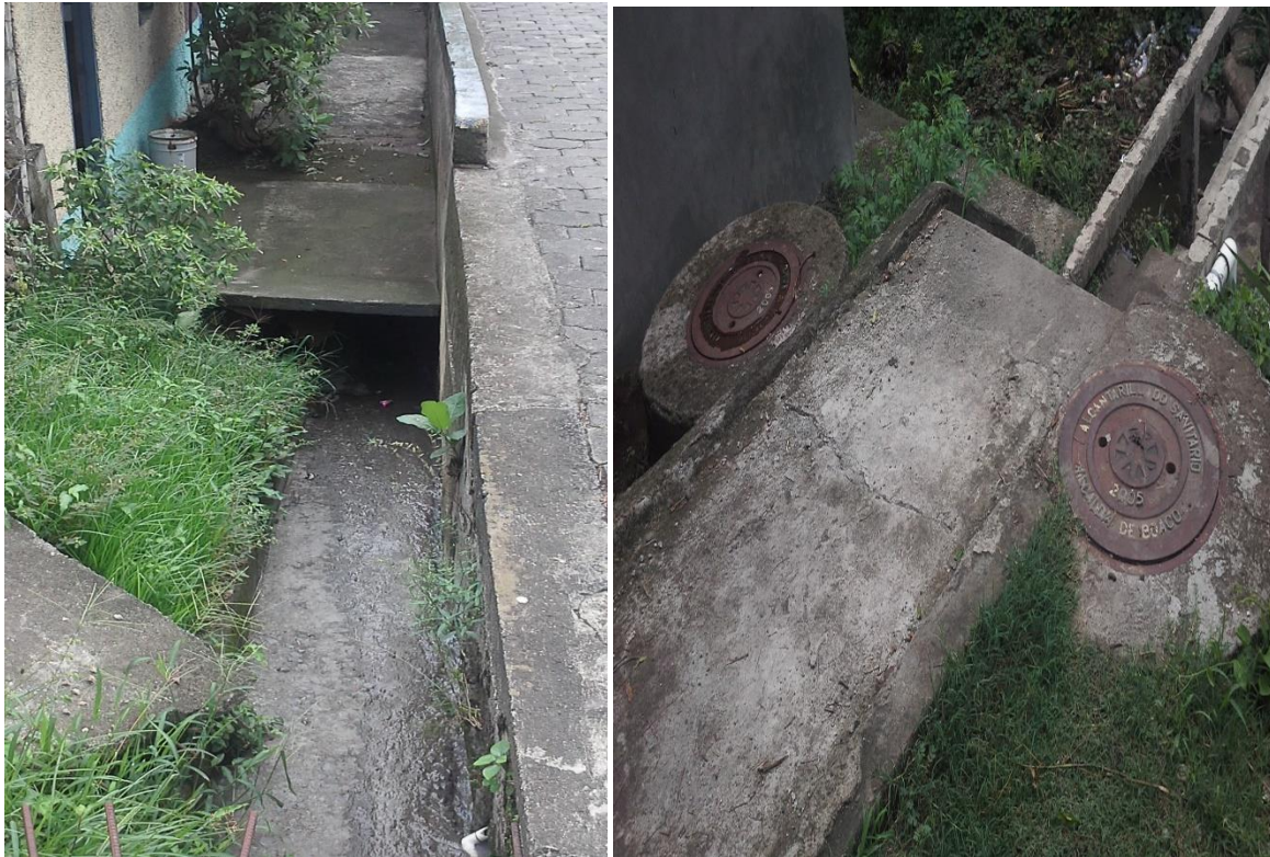
Inicio del canal 1
